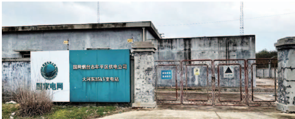
圖16-3：大河東變電站
