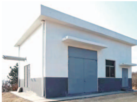
柴油發電機室
