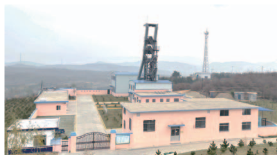
輔助豎井工地
